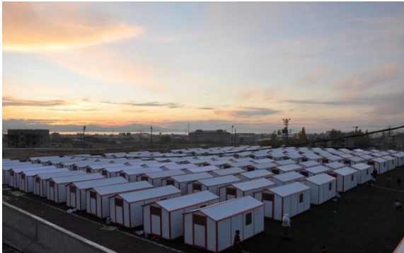
政府から支給された断熱パネルでできたプレハブ仮設住宅「メブラナ」が並ぶワン市内の避難キャンプ(2011/11/2 撮影)
