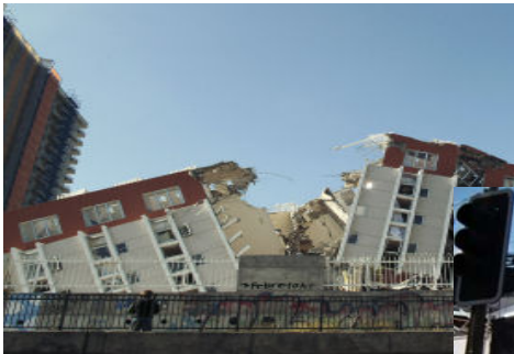
↑地震直後に倒壊したビル
