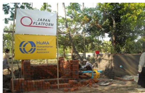
HuMAとJPFの旗を掲げて井戸掘削を行う現地業者
