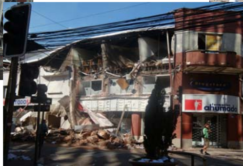
↑街中で倒壊した建物
