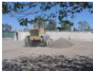
新しい土地の整地工事
