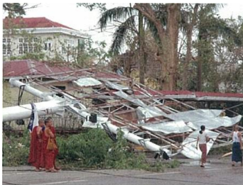
被災状況 (当時)
