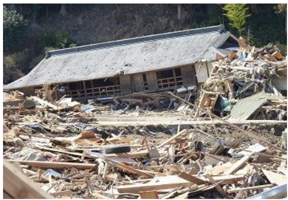
南三陸町志津川地区は壊滅的な状況
