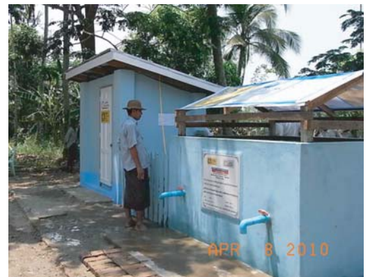
写真② 今回設置した井戸。手前が貯水層、奥がエンジン小屋。
