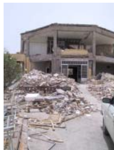
写真(1) 補修工事中のアルファトニアン病院
