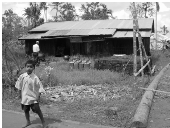
現在運営中の仮SRHC。保健婦宿泊施設として再建される予定
