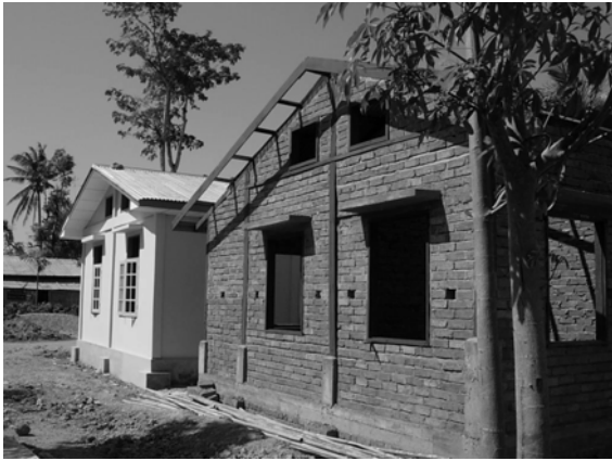
裏から見た建設中の SRHC(左)と 保健婦宿泊施設(右)
