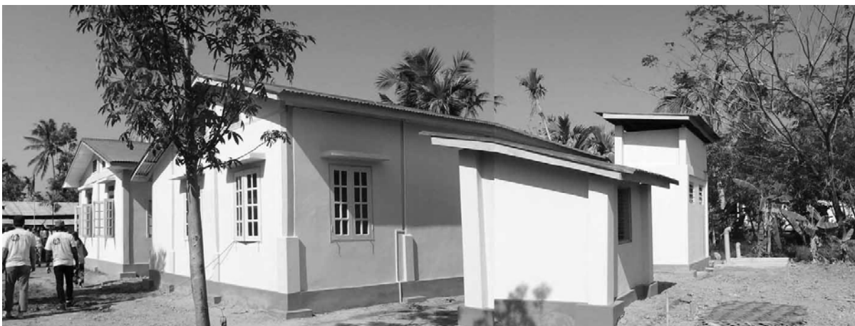
裏から見た完成した KCCP 村医療施設 SRHC (左) と 保健婦宿泊施設 (中央)。手前 2 つの建物はトイレ
